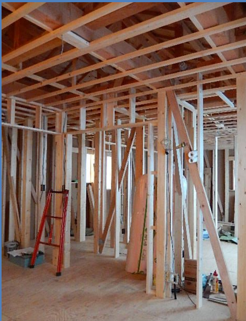
木工事進行中
